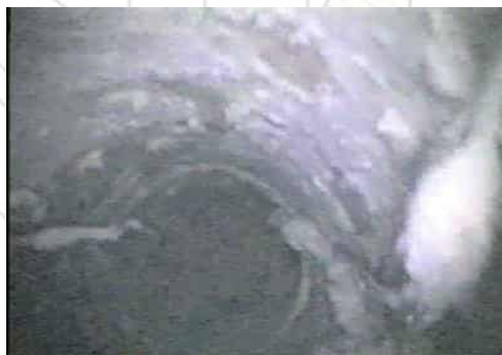
Биопленки в трубах при использовании гипохлорита натрия
